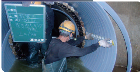
下水管・雨水管の更生・補修工事
