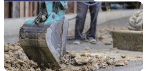
職場環境の設備改善、土木一般
