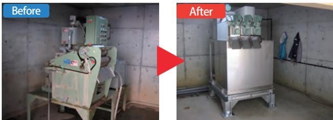
ベルトプレス (脱水能力3kgDS/時) からスクリーブレス (脱水能力18kgDS/時) へ更新
