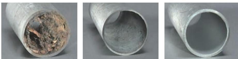
排水管内を洗浄してサビや汚れを完全に取り除き、超強力吸引車を使って特殊樹脂をコーティングします。
