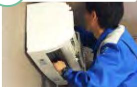
外せる部品を取り外して、分解します。
