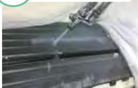
専用機材で内部を徹底的に洗浄します。
